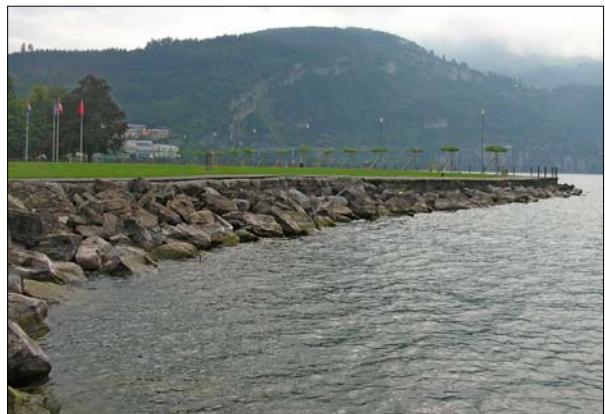
Ufersituation Transekt 51. Uferbefestigung mit Blockschüttung. Linker Bildrand: Südliche (seeseitige) Hafenmole des Föhnhafens Brunnen.
