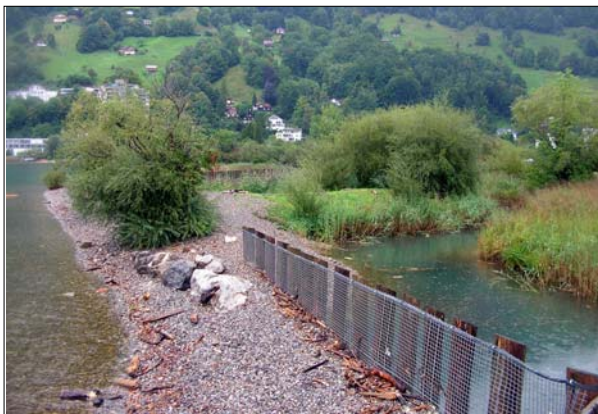
Geschwemmselzaun und vorgelagerter Wellenschutz (Kiesschüttung) vor den Gräben des Naturschutzgebietes Hopfräben. Blick Richtung Nordwesten. Im Vordergrund kurzer Zaun im Bereich der Transekte 18 und 19, im Hintergrund langer Zaun (siehe vorhergehendes Bild) im Bereich der Transekte 15 und 16. Im Bild Rechts die Gräben und Röhrichtbestände im ufernahen Bereich des Naturschutzgebietes.
