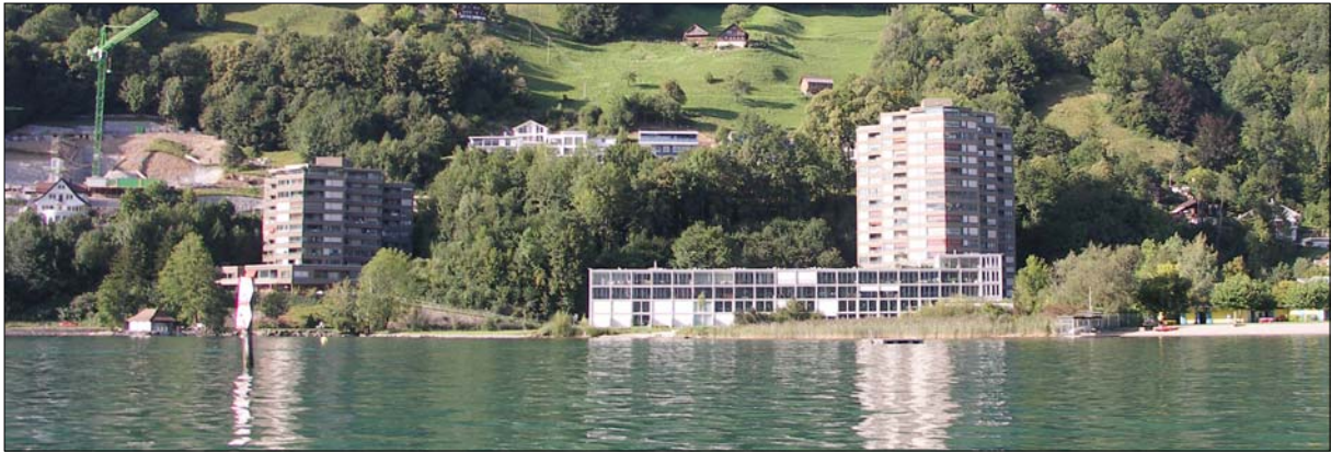
Ufersituation Transekte 1 - 3. Bildmitte. Gebäudekomplex «Schilf», Wohnungen und Restaurant mit Seeanstoss (Gersauerstrasse 85). Rechts: Strandbad Hopfräben.
