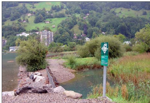
Geschwemmselzaun und vorgelagerter Wellenschutz (Kiesschüttung) vor den Gräben des Naturschutzgebietes Hopfräben. Blick Richtung Nordwesten. Im Vordergrund kurzer Zaun im Bereich der Transekte 18 und 19, im Hintergrund langer Zaun (siehe vorhergehendes Bild) im Bereich der Transekte 15 und 16. Im Bild Rechts die Gräben und Röhrichtbestände im ufernahen Bereich des Naturschutzgebietes.
