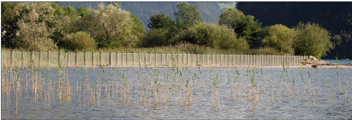
Geschwemmselzaun und vorgelagerter Wellenschutz (Kiesschüttung) vor den Gräben des Naturschutzgebietes Hopfräben. Im Vordergrund lockerer Schilfbestand bei Transekt 15.
