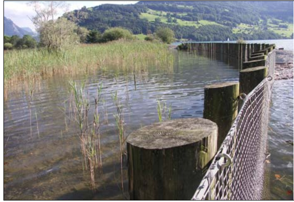
Geschwemmselzaun und Wellenschutz vor dem Naturschutzgebiet Hopfräben. Blick Richtung Südwesten (nach Treib).
