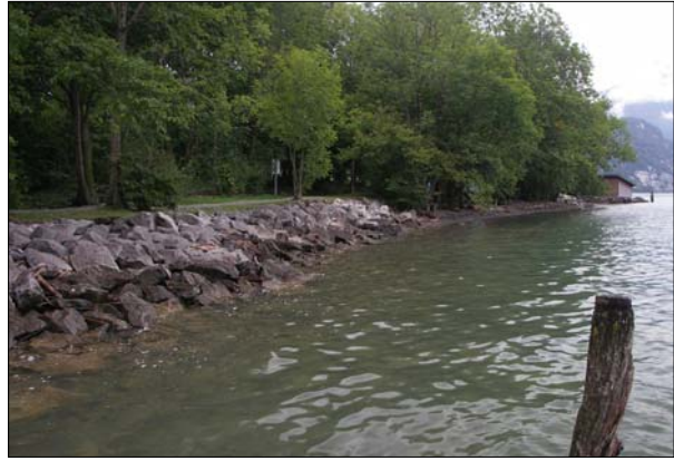
Uferschüttung mit Blockwurf und Kies auf der südwestlichen Seite des Naturschutzgebietes Hopfräben. Bereich der Transekte 20 - 34 (= Abschnitt des Kiesabbaus in der Flachwasserzone). Bild links: Nordwestlicher Bereich der vorgelagerten Uferschüttung. Bild rechts: Südöstlicher Abschnitt. Ganz rechts Bootshaus vor dem Campingplatz bei Transekt 34.
